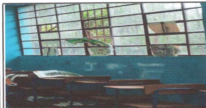
Foto 5: Pintura en muros interiores.
